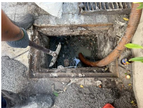
ภาพที่ 2.2-22 การขุดลอกท่อระบายน้ำ
