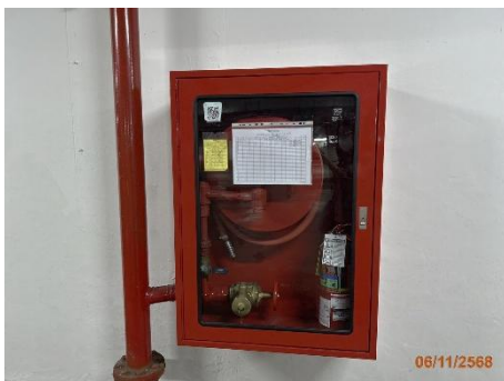
ภาพที่ 2.2-35 ตู้เก็บสายฉีดน้ำดับเพลิง พร้อมอุปกรณ์ (Fire Hose Cabinet : FHC)
